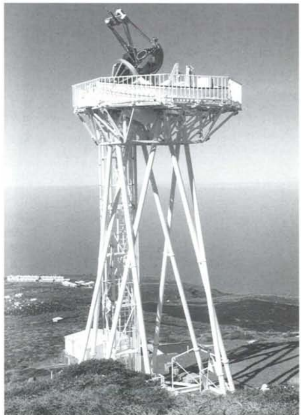
Figuur 3: De DOT in werking. Let op de rubberen dempers halverwege iedere torendriehoek die er voor zorgen dat de staven op elkaar dempen bij het eventueel aanslaan in de wind.
