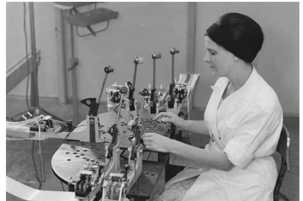
In de elektronica montage pakken de door Wil Lenders ontwikkelde klapklauwen onderdelen die in een band worden aangevoerd (zie de close-up boven).
