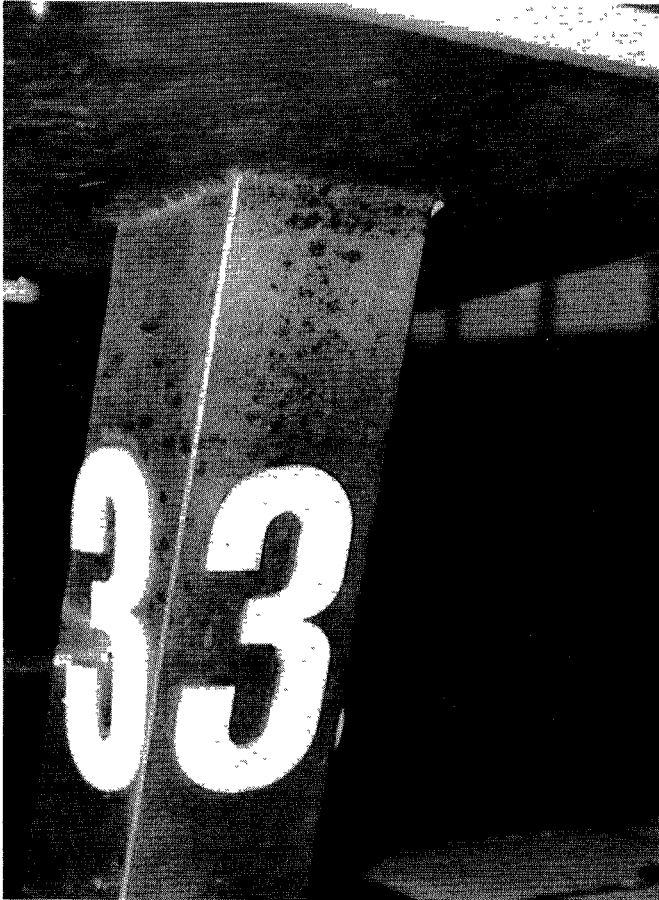
Figuur 5 Corrosie van een roestvast stalen startblok in een zwembad met chloorhoudend water.
